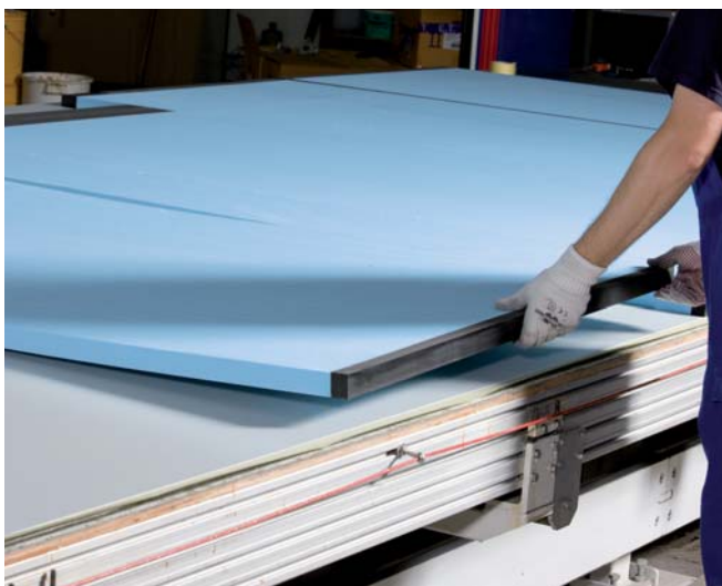
Fig. 10: Posizionamento dei pannelli STYROFOAM™
