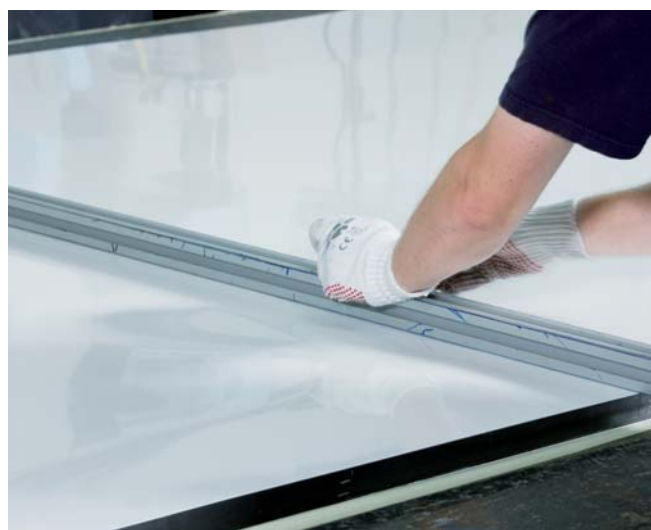
Fig. 13: Messa a registro per l'installazione
